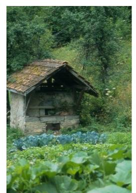
Autrefois, la voûte était montée en granit ou en lauzes (schiste). Il y avait dans la commune un maçon spécialisé dans la construction des fours. La sole présente une pente de 5 cm/m. Pour construire la voûte, le maçon se tenait au centre de la sole et montait les pierres autour de lui.
